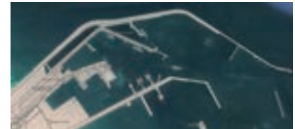
Ras Laffan LNG export port in Qatar
