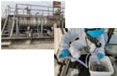
LPガス着臭設備無害化工事の作業風景
