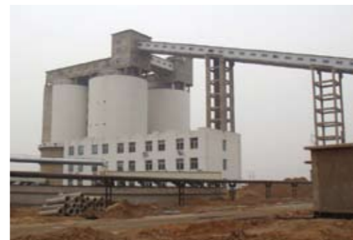
建設中の洗炭工場
