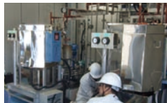
「水素分離膜」設置工事中
