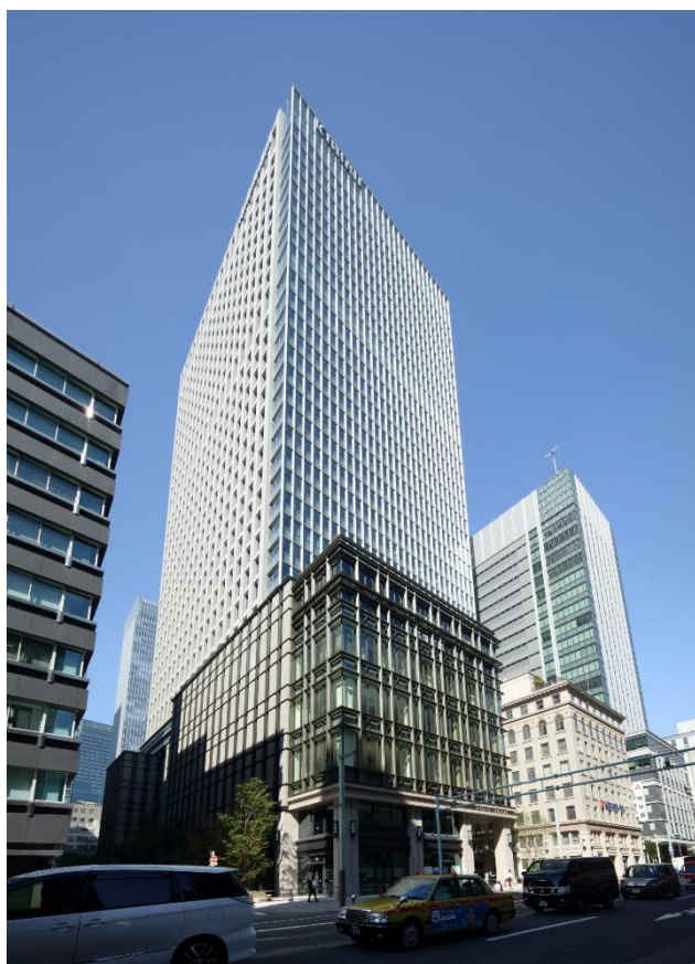
京橋エドグラン 外観
