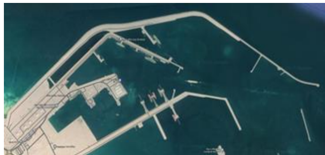
弊社 LA が納品される、ラスラファン LNG 輸出港
