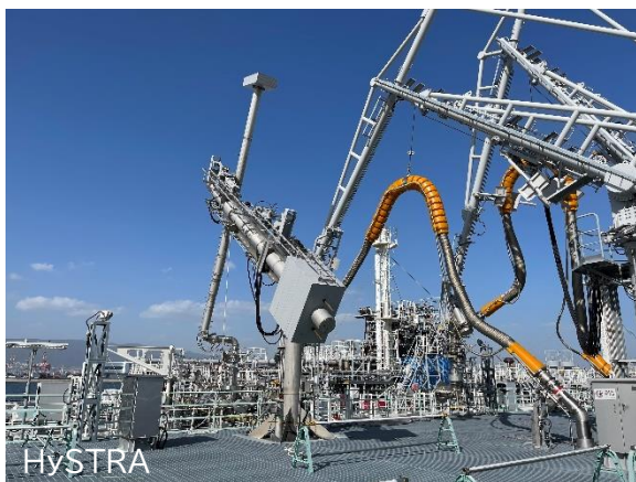
【タンカーと接続中の鋼管型液化水素用ローディングアーム】
