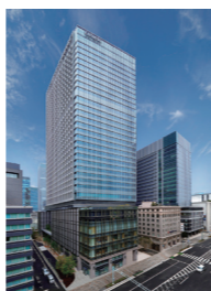
京橋エドグラン外観
