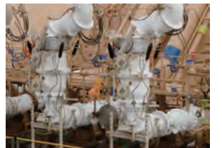
緊急離脱装置 (ERSユニット)
