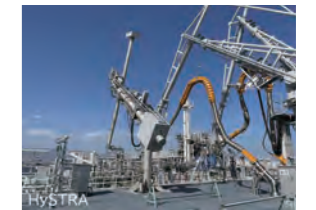
液化水素用鋼管型ローディングアーム 川崎重工業株式会社との共同開発 画像提供: 神戸水素基地 (Hy touch神戸/HySTRA)
